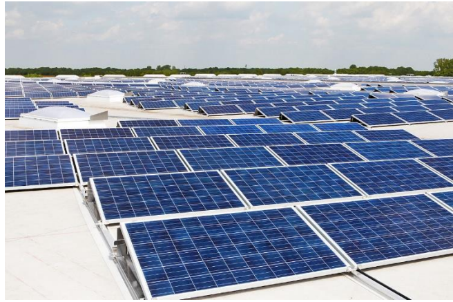
Photovoltaik Dachanlage Hannover - Schwarze Heide - 1 MW.jpg
